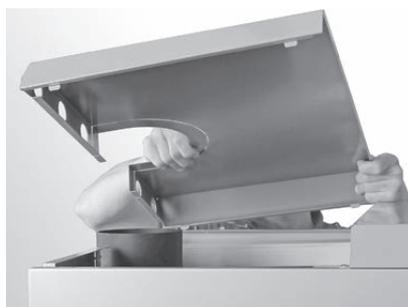
Fig. 61 Togliere la copertura della caldaia sul retro
